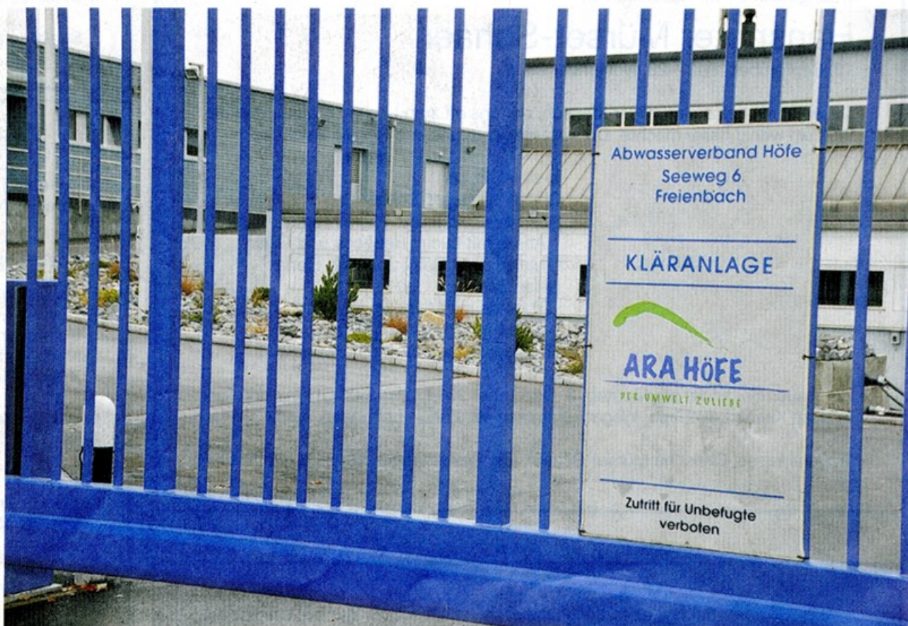
Die ARA Höfe ist in Sachen Mikroverunreinigungen bereits einen Schritt weiter; sie hat im Zusammenhang mit der Erweiterung ein zusätzliches Becken erstellt.
