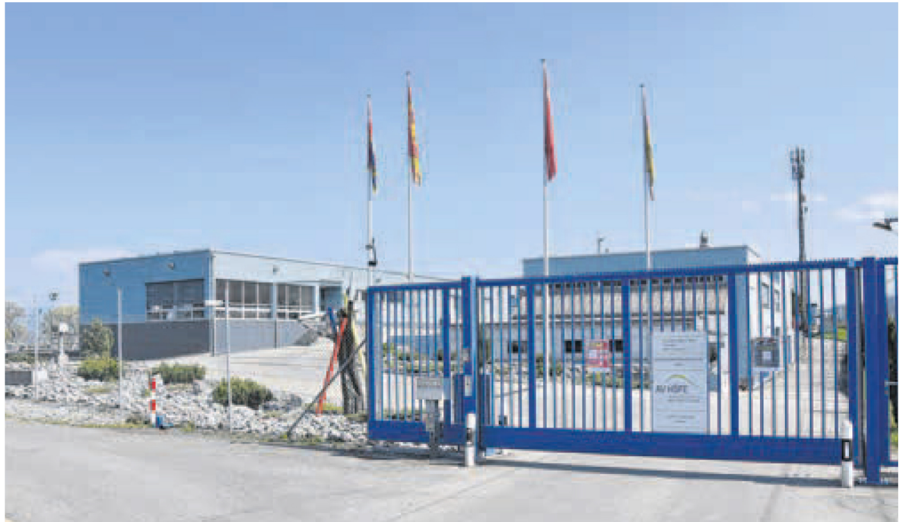
Die ARA Höfe in Freienbach soll in Zukunft auch die Abwässer aus dem Raum Einsiedeln und Ybrig reinigen.
