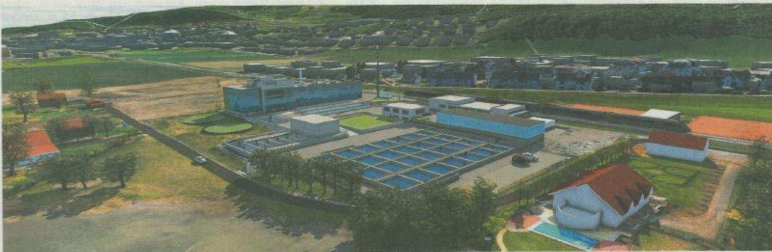
Im vorliegenden Vorprojekt wird die bestehende Schlammbehandlung komplett zurückgebaut und die neue Anlage kommt an demselben Standort zu liegen. Die Visualisierung zeigt das grösstenteils zu ersetzende, höchste Gebäude links im Bild. Bild zvg
